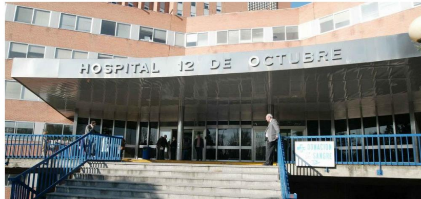
Fachada del Hospital 12 de Octubre (Foto. Comunidad de Madrid)
